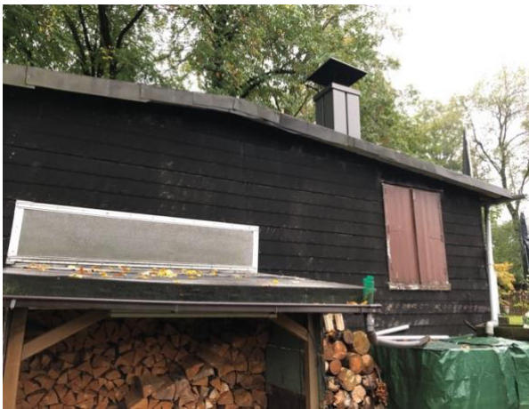
Abb.10: Schützenhaus von Norden
