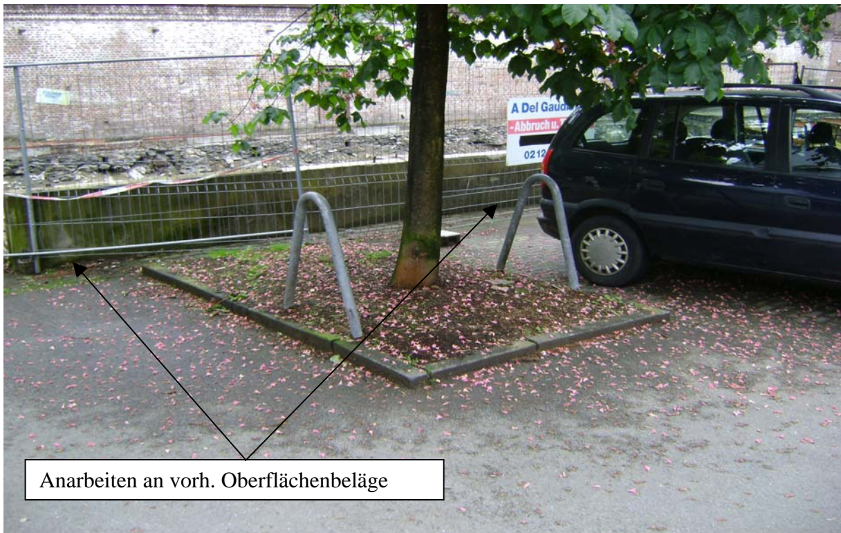
Abarbeiten an vorh. Beläge
