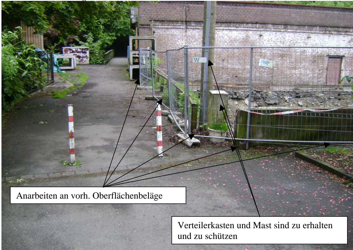
Abarbeiten an vorh. Beläge
